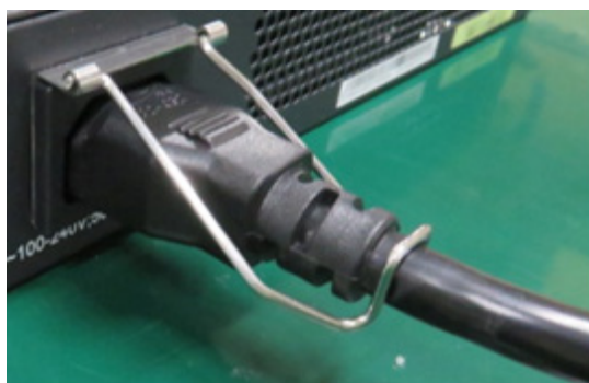
図 3-22 装置への電源ケーブルの接続
