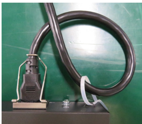
図 3-23 AC 電源ケーブルの固定
